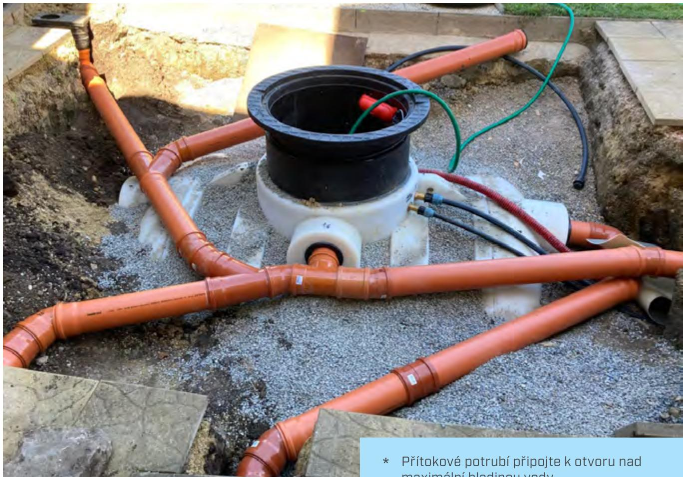
\* Přítokové potrubí připojte k otvoru nad maximální hladinou vody.
